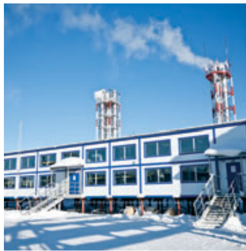
Котельная на новой Базе бурения БНГКМ.
